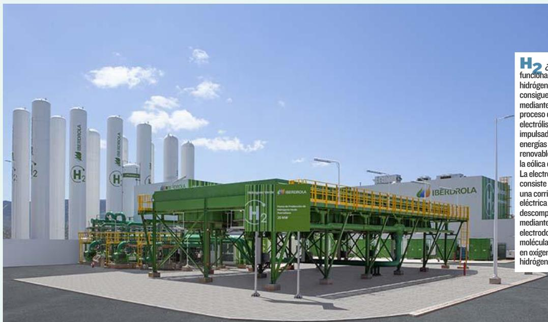
**H<sub>2</sub>** ¿Cómo funciona el hidrógeno? Se consigue mediante un proceso de electrólisis impulsada con energías renovables como la eólica o la solar. La electrólisis consiste en utilizar una corriente eléctrica para descomponer mediante electrodos la molécula del agua en oxígeno e hidrógeno.
